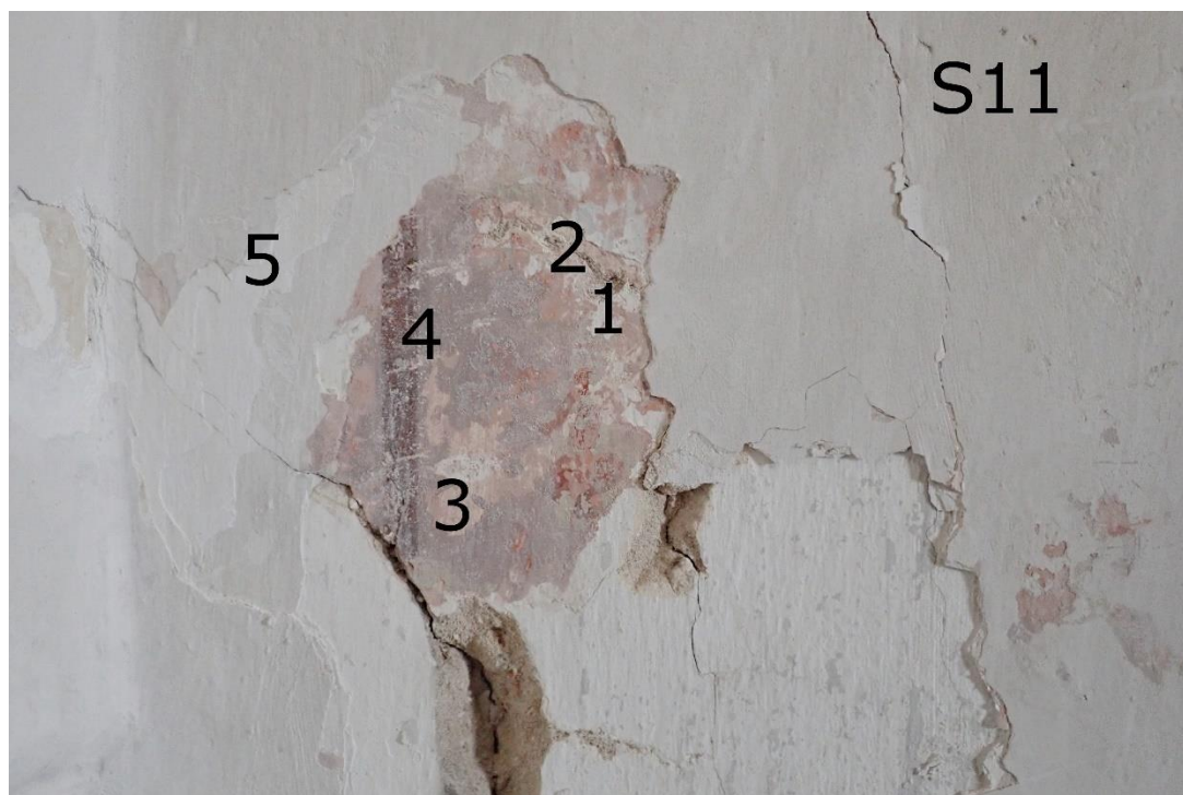
Obrázek 17 – Sonda S11 – hladká plocha – 1. vrstva – bílá; 2. lomená bílá; 3. světle růžová; 4. růžová + červená linka; 5. několik vrstev bílé.
