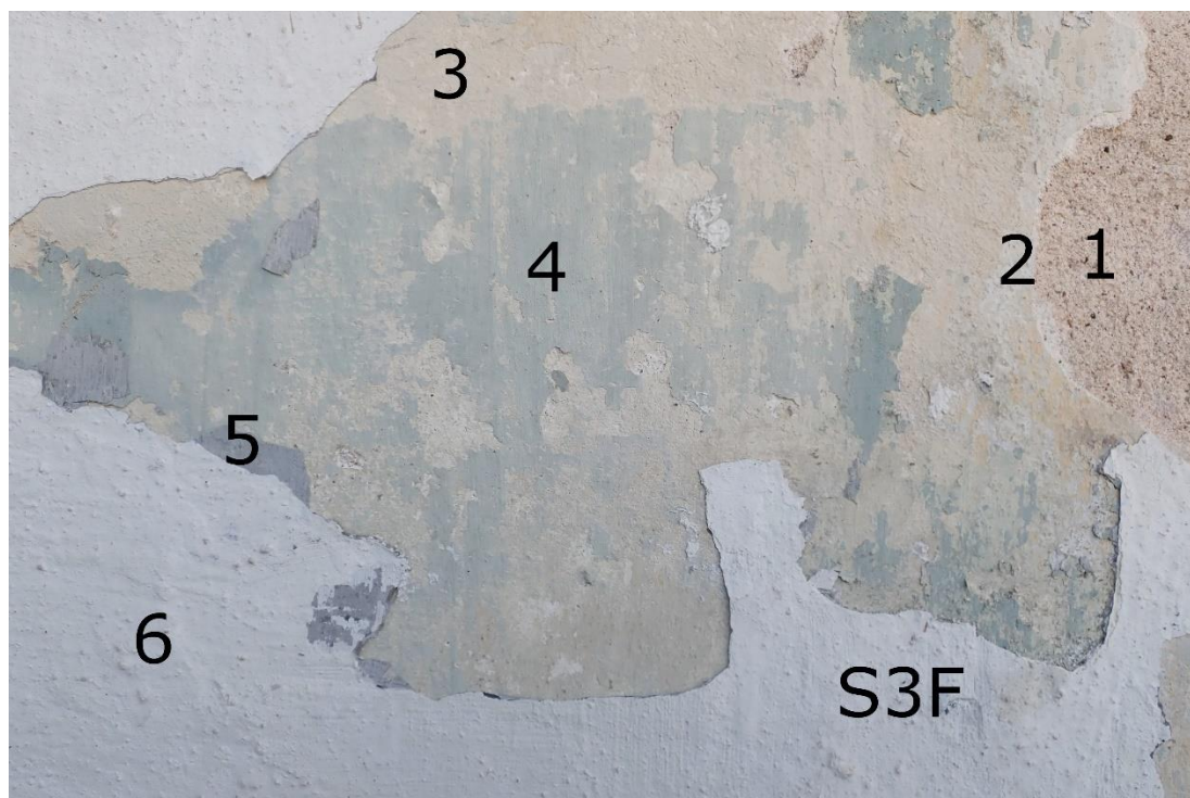
Obrázek 37 – Sonda S3F – severní strana fasády – 1. vrstva – štuk; 2. lomená bílá; 3. světlý okr; 4. šedozelená; 5. šedá; 6. současný bílý nátěr.
