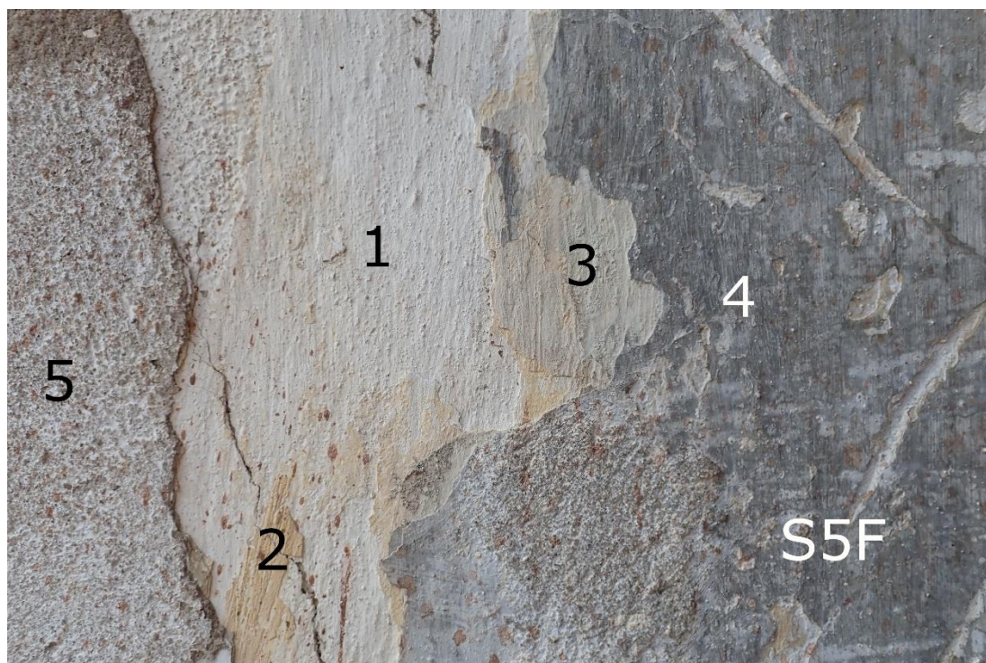
Obrázek 45 – Sonda S5F – východní strana fasády (vedle domovních dveří ze zahrady) – 1. vrstva – lomená bílá; 2. okr; 3. lomená bílá; 4. tmavě hnědo-šedá; 5. hrubá novodobá omítka.
