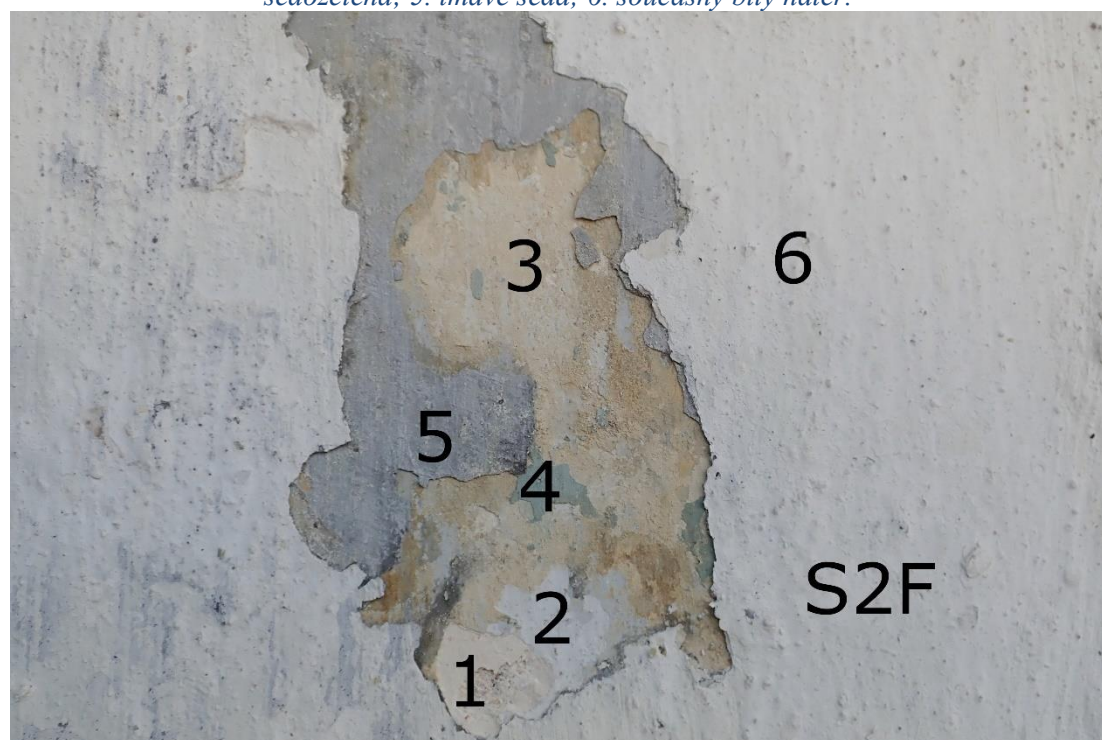
Obrázek 36 – Sonda S2F – severní strana fasády – 1. vrstva – lomená bílá; 2. bílá; 3. okr; 4. šedozelená; 5. šedá; 6. současný bílý nátěr.
