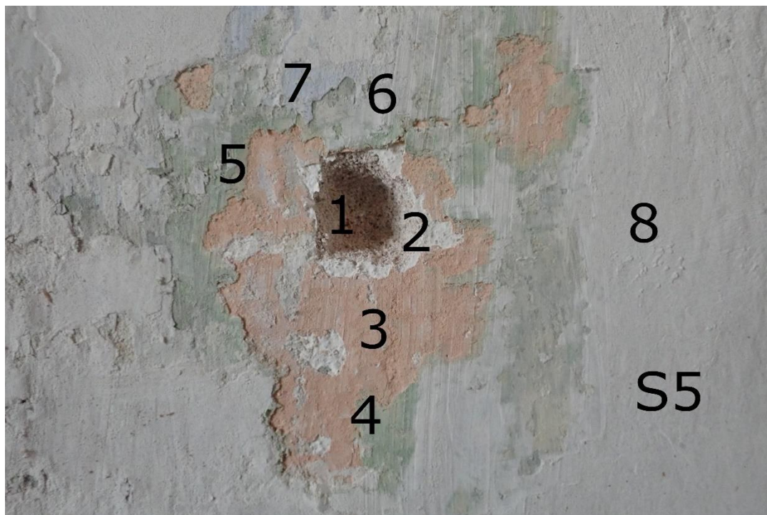
Obrázek 7 – Sonda S5 – hladká plocha – 1. vrstva – štuk; 2. bílá; 3. skořicová; 4. zelenkavá; 5. fragmenty zelené; 6. světle šedá; 7. světle modrá; 8. současný bílý nátěr.
