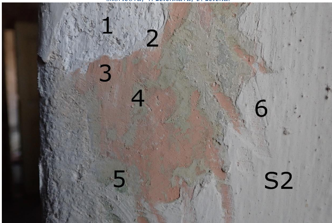
Obrázek 4 – Sonda S2 – okenní špaleta – 1. vrstva – bílá; 2. lomená bílá; 3. skořicová; 4. béžová; 5. zelenkavá; 6. současný bílý nátěr.
