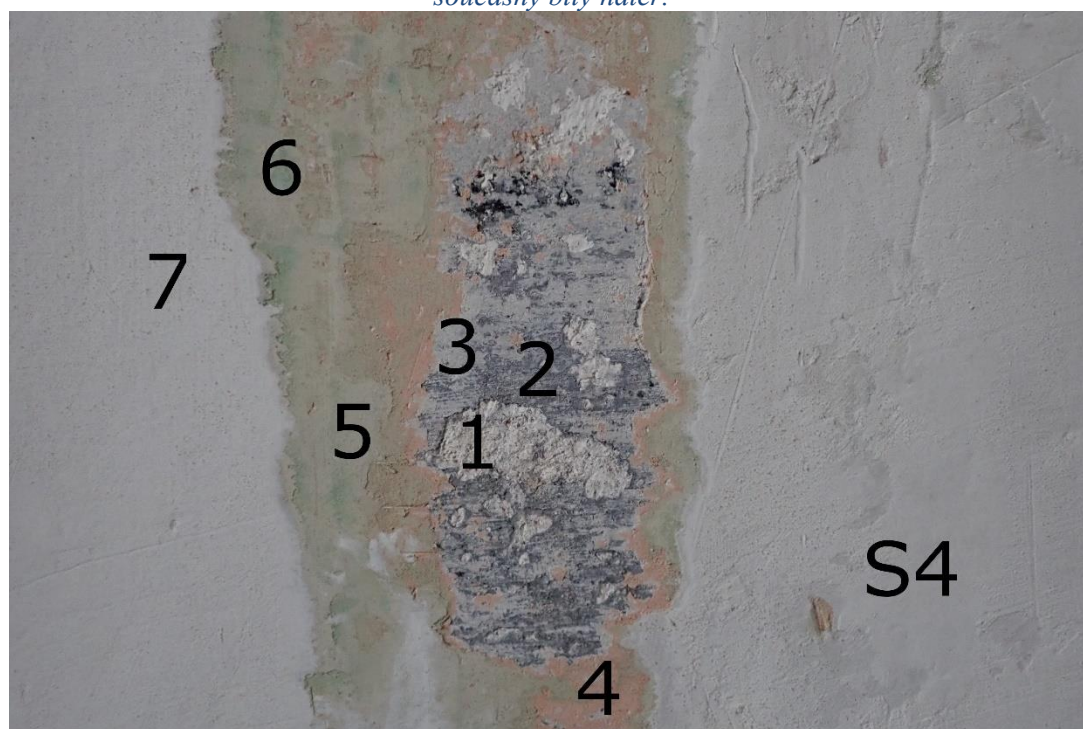
Obrázek 6 – Sonda S4 – sokl – 1. vrstva – bílá; 2. tmavě šedá s černou linkou; 3. béžová; 4. skořicová; 5. zelenkavá; 6. fragmenty zelené; 7. současný bílý nátěr.
