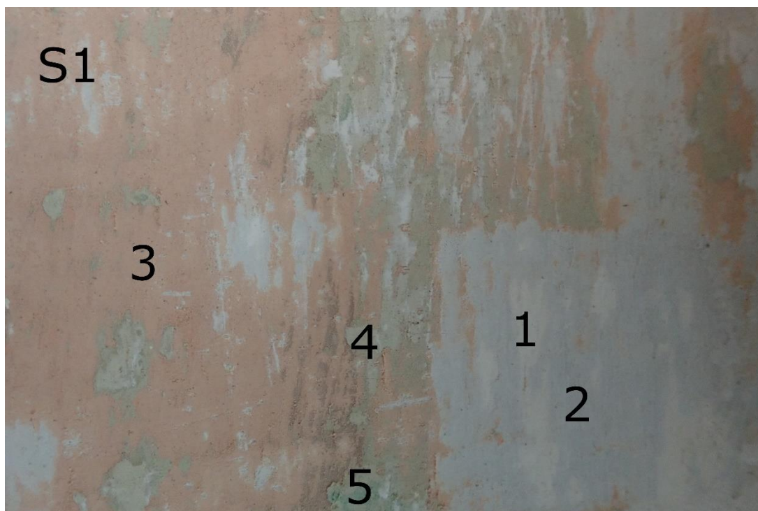
Obrázek 3 – Sonda S1 – okenní špaleta – 1. vrstva – několik vrstev bílé; 2. světle modrá; 3. skořicová; 4. zelenkavá; 5. zelená.
