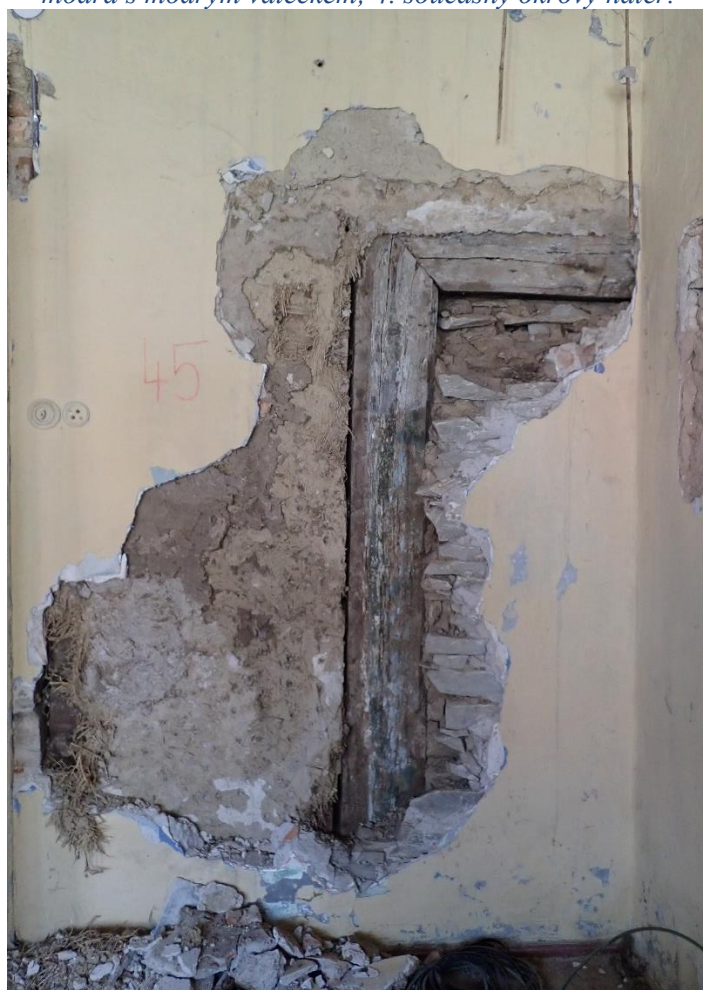
Obrázek 32 – Zazděný raně barokní trámkový portálek [1] s hliněnou omítkou – místnost 1.07.
