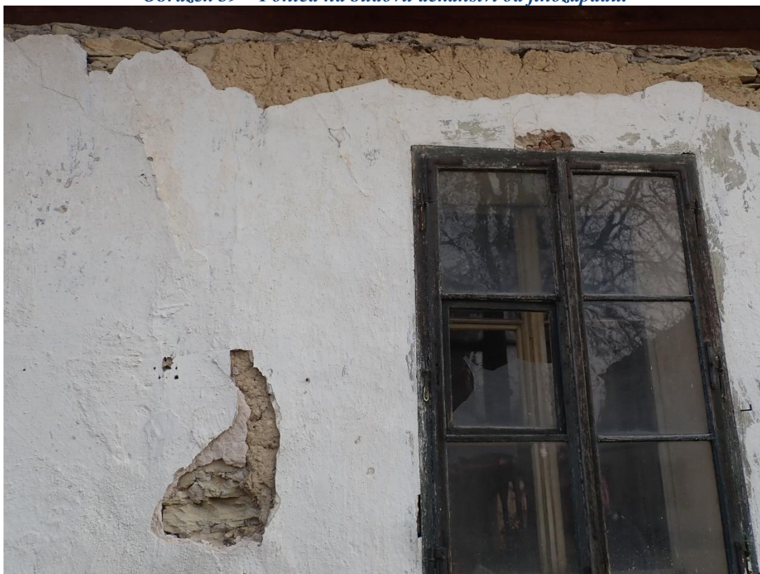
Obrázek 40 – Pohled na fragmenty odhalené hliněné omítky na pravé části západní fasády.
